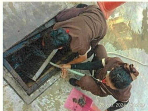
รูปที่ 26 ทำความสะอาดตะแกรงดักมูลฝอย
